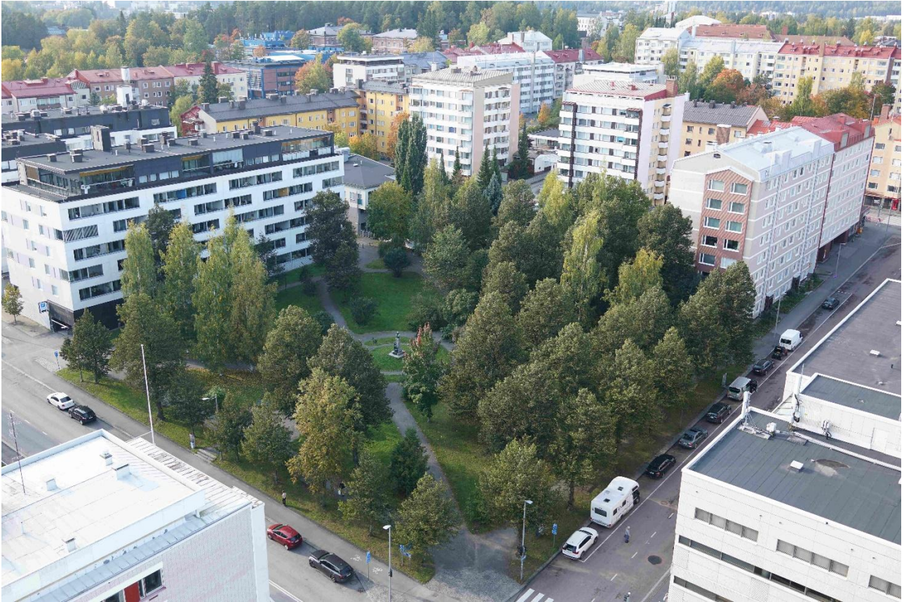
Ilmakuva Cygnaeuksen puistosta koillisen suunnasta (9/2024)
